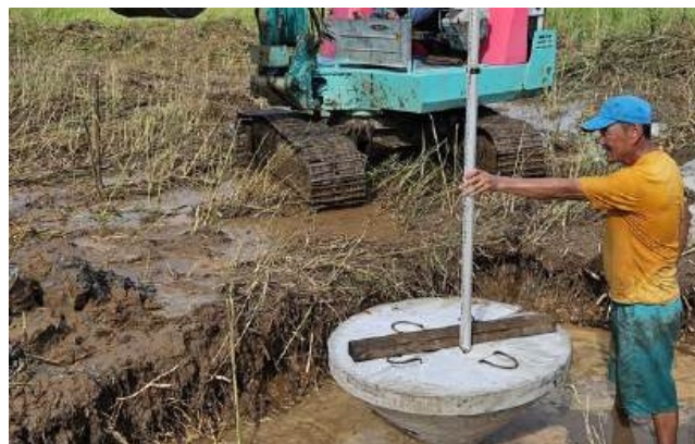
Thi công VTopbase trên nền đất bùn chảy — không cần ép cọc đại trà
