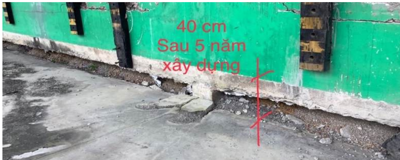
Tường bao tách khỏi nền — lún 40 cm sau 5 năm xây dựng
