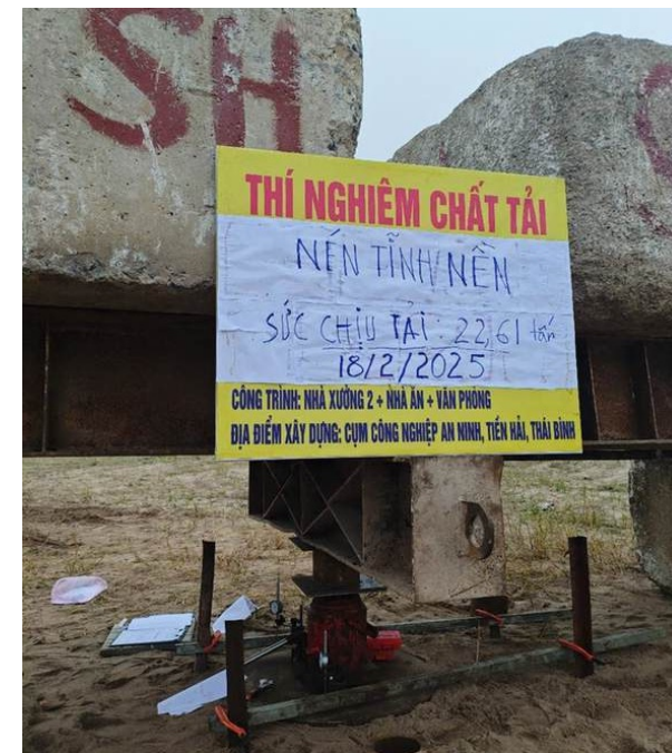
Nén tĩnh nền — Xưởng khăn Thái Bình (Hưng Yên)
