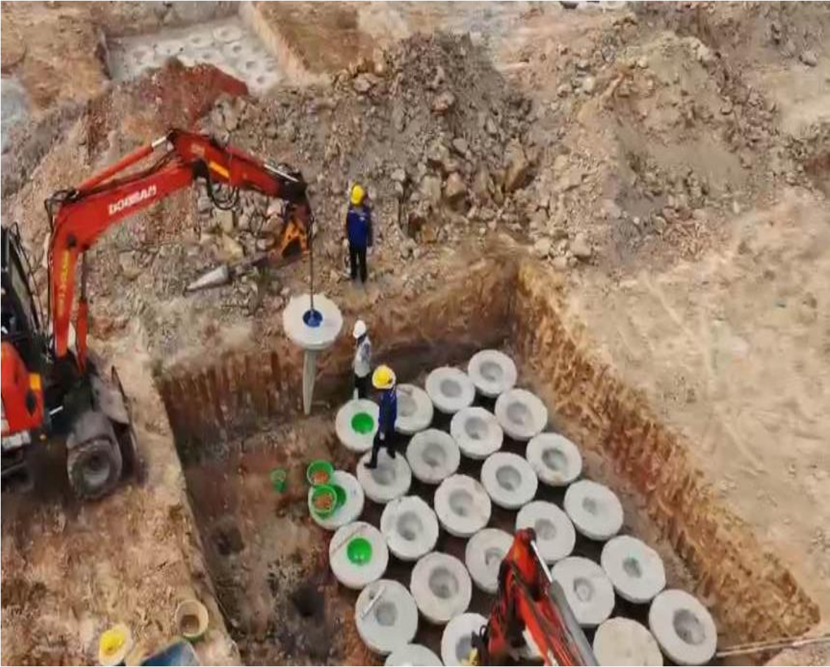
Thi công hệ VTopbase tại dự án — mặt bằng mở, tốc độ cao
